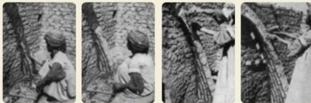
SEQUENZA DELLA COSTRUZIONE DI UNA VOLTA A CORSI INCLINATI CHE SI APPOGGIANO A UN MURO DI FONDO
