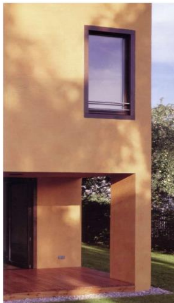
4) Sostituire i serramenti, spostandoli a filo esterno del nuovo sistema di parete
