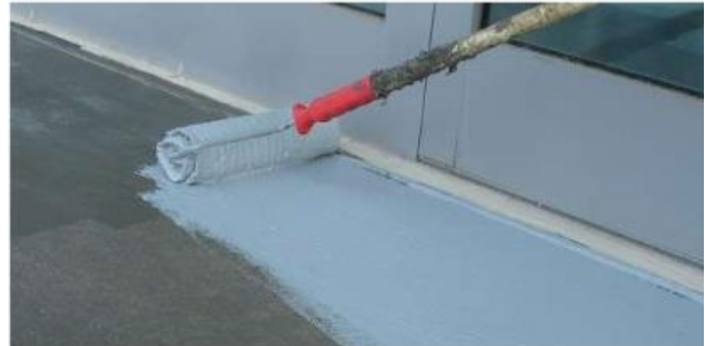
Impermeabilizzanti sintetici in materiali polimerici
