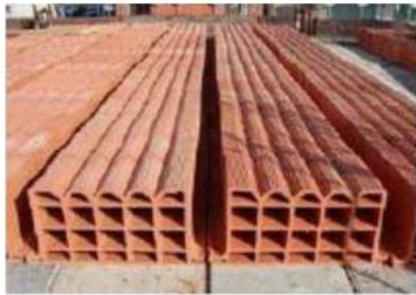
2. Posizionamento delle pignatte
