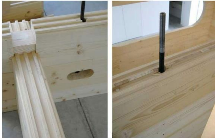
Tiranti metallic verticali a vite (serrati tramite bulloni e rondelle) per bloccare ulteriormente la connessione d'angolo
