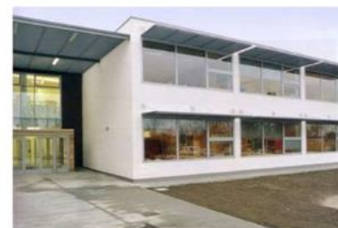
Attacco a terra del sistema a cappotto risolto con un leggero arretramento dello strato isolante (ampliamento scuola elementare, Brugnera. Pordenone, 2004-07)
