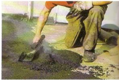
Impermeabilizzazione ad asfalto colato (miscela di asfalto, bitume e sabbia/pietrisco)
