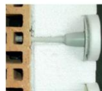
Tassello di fissaggio con rondella di copertura a incasso
